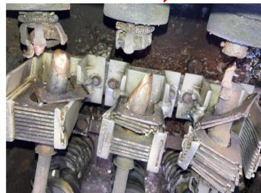
③一次側固定接触部の破損状態
