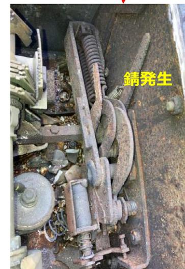
②壁・操作ハンドル機構部の破損状態
