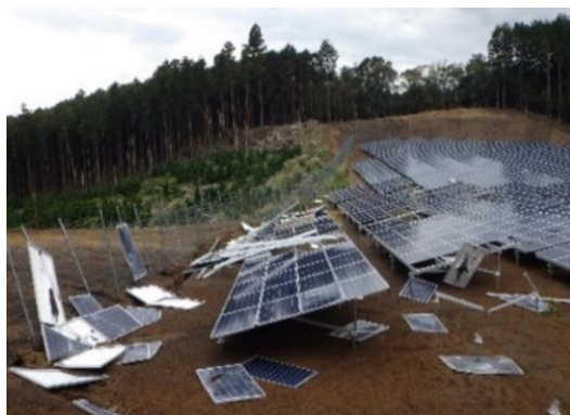
【図1】台風時の強風による事故被害写真 出典：「電力安全小委員会の各ワーキンググループにおける検討事項等について」（経済産業省 第22回産業構造審議会 保安・消費生活用製品安全分科会 電力安全小委員会）
