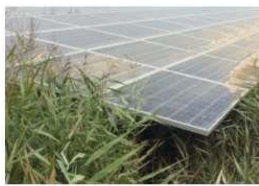
【図2】台風時の水害により発電設備が水没した事例 出典：「太陽光発電の環境配慮ガイドライン」（環境省）
