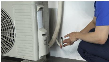
ドレンホースを確認
