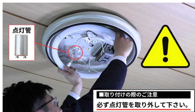
不適切なランプ交換をしている様子
