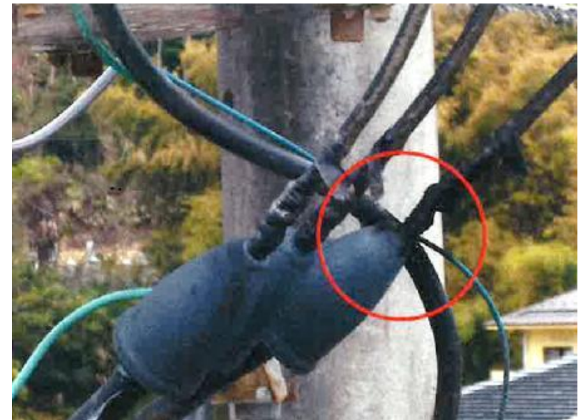
PAS制御線と高圧引込ケーブルの接触箇所（拡大図）
