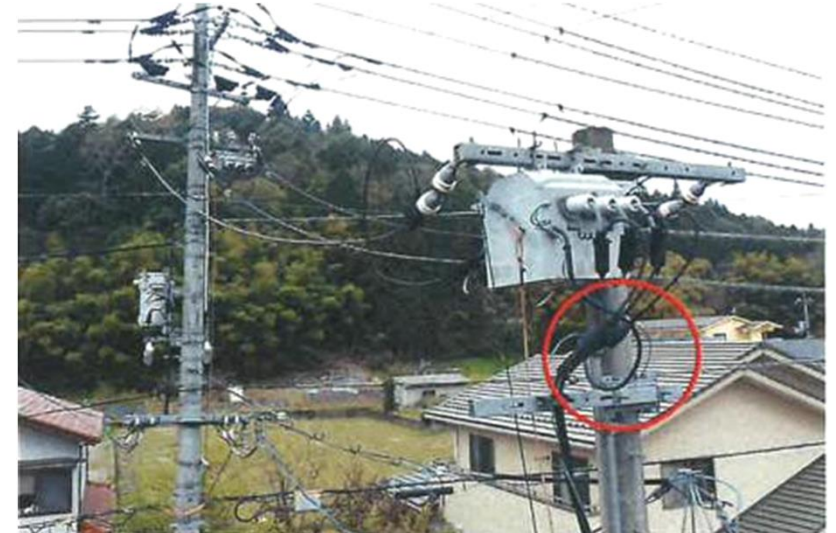
PAS制御線と高圧引込ケーブルの接触箇所（拡大図）
