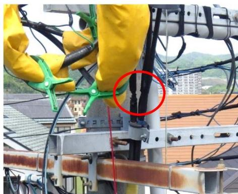
写真2 事故ケーブルの設置状況
