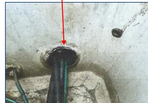
水トリーが発生した地中埋設高圧引込ケーブル（約75m地点）
