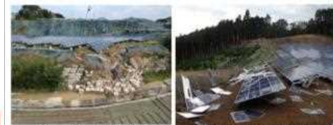
【図1】台風の大雨による事故被害
