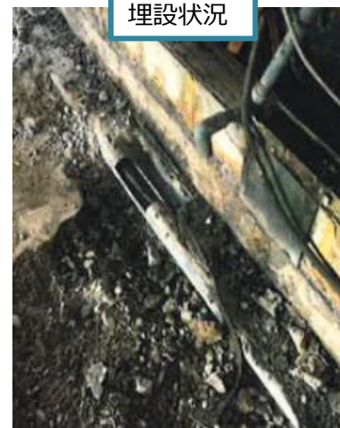
高圧配管 埋設状況
