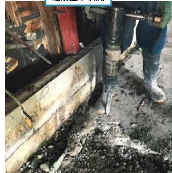
掘削工事状況
