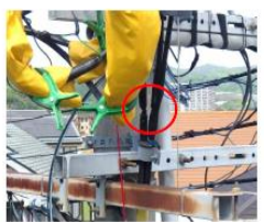
写真2 事故ケーブルの設置状況
