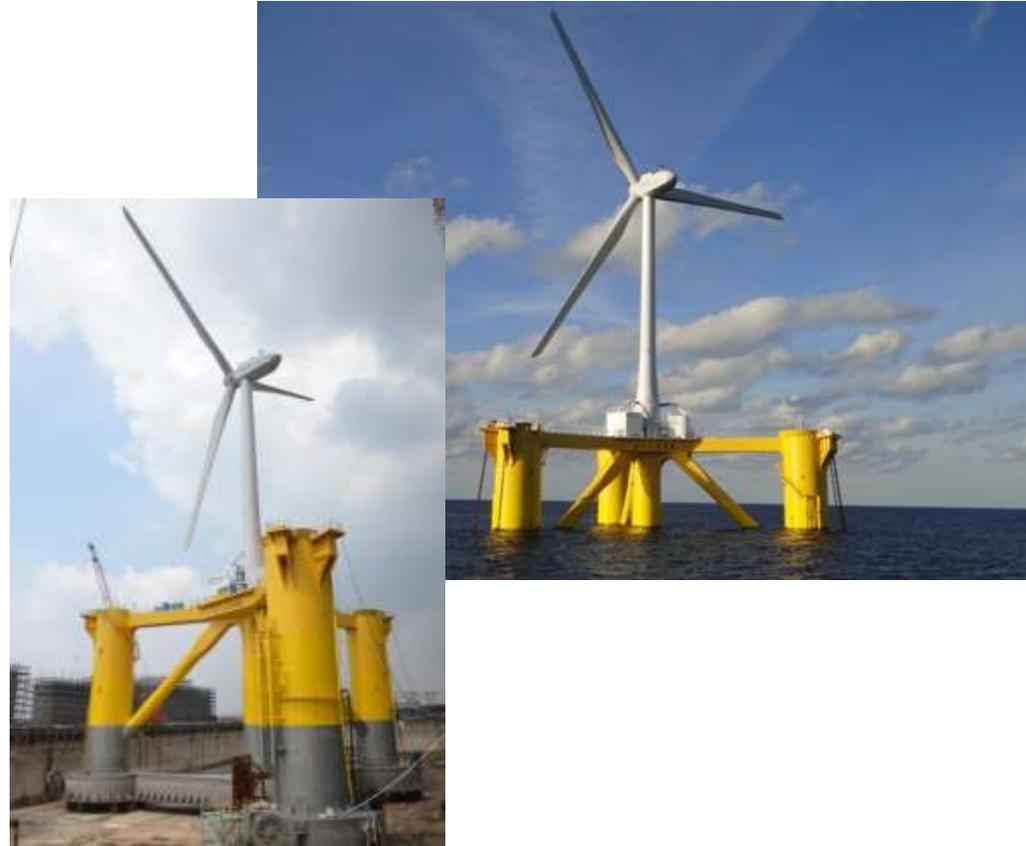
2MW風車搭載浮体式洋上風力発電設備
