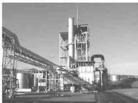
有機塩素系排ガス燃焼設備（液中燃焼式）
