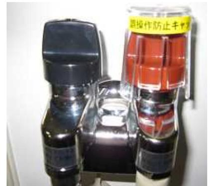
(写真) ガス栓の誤操作防止キャップ
